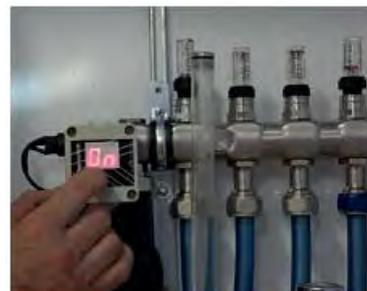
Включите блок управления (15) узла, нажав кнопку на контроллере. На дисплее загорится **-On-**. Нажимая на кнопку, установите температуру теплоносителя (диапазон установки 5-50°C с шагом 1°C).
