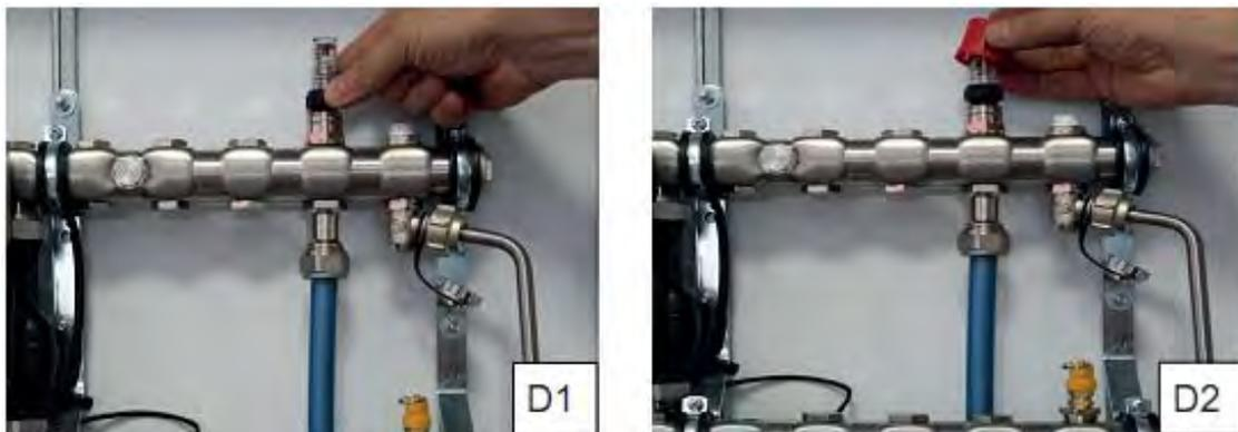
E. С помощью крышки-ключа закройте один из клапанов заполнения/слива (12) на напорном или возвратном коллекторе, перекрыв, тем самым, переток теплоносителя через байпас.
