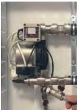
F. Подключите шланг системы заполнения к сервисному клапану (20) заполнения/слива на возвратном (нижнем) коллекторе узла. Откройте клапан заполнения-слива (20).
